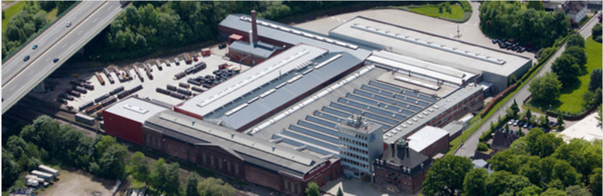
Das Firmengelände am Standort Hagen.
