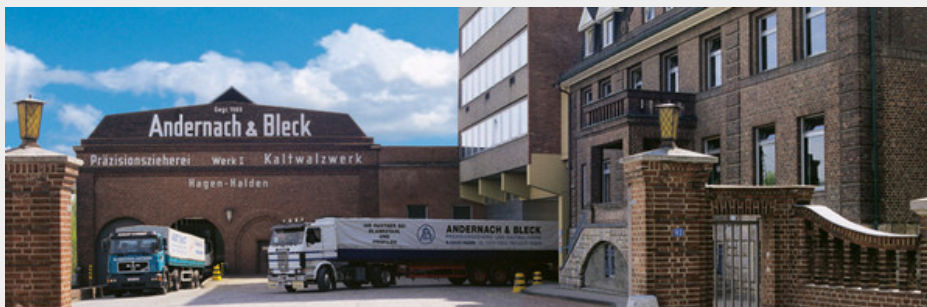
Das historische Gebäude am Standort Hagen - heute.
